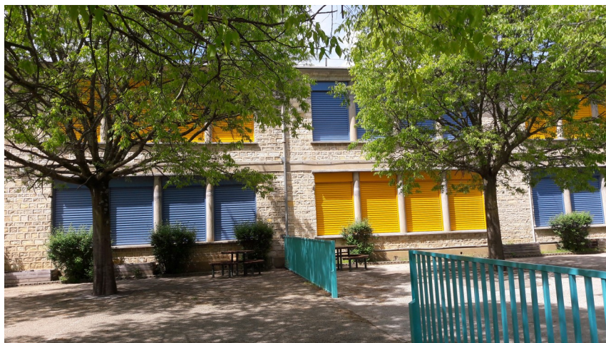
Façade de l'école avec les nouveaux stores électriques extérieurs
