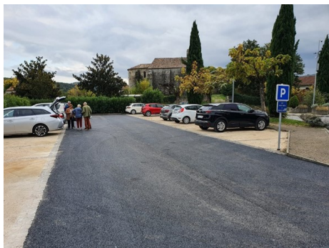
Réfection de la place du marché au centre du village. Les places et la clapissette ont été rénovées par les agents municipaux et l'enrobé réalisé par Bernard TP
