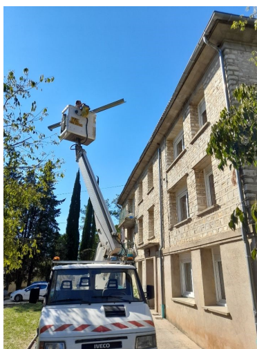
Réparation des canaux du bâtiment « des instituteurs »
