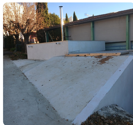
BÉTON POUR ACCÉDER AU SILO DE LA CHAUDIÈRE DE LA SALLE POLYVALENTE
