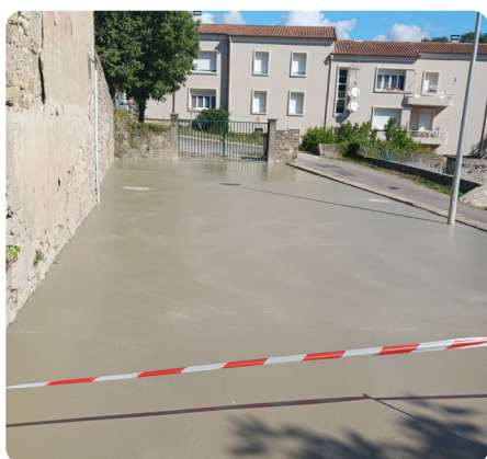
ENTRÉE BÉTON BALAYÉ AUX SERVICES TECHNIQUES
