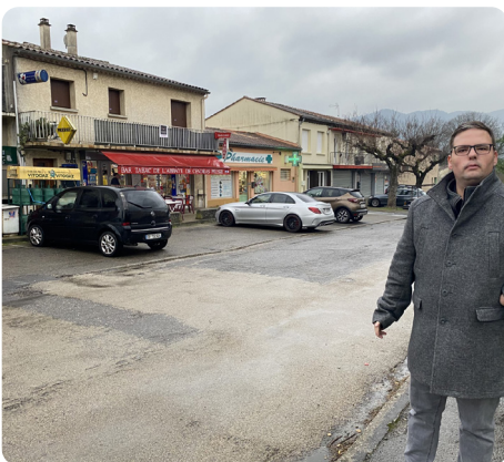
Rénovation du centre-village : un nouveau visage pour Cendras P.4/5
