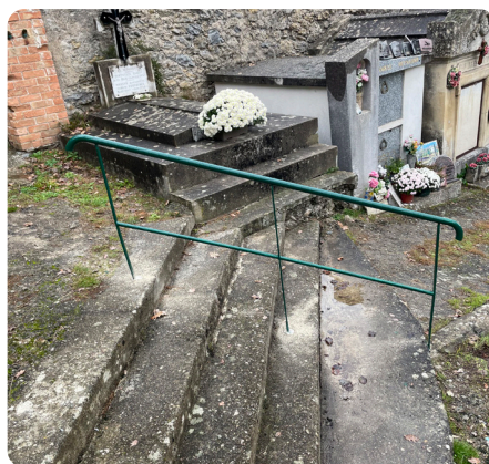
RÉALISATION D'UNE RAMPE D'ESCALIER AU CIMETIÈRE LE PUECH
